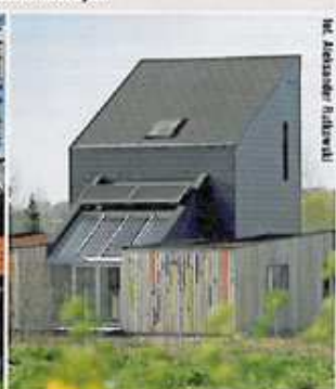
↑ Dom w Pszczyńcu – architektura w służbie poszanowania energii. Projekt: Piotr Kuczia
